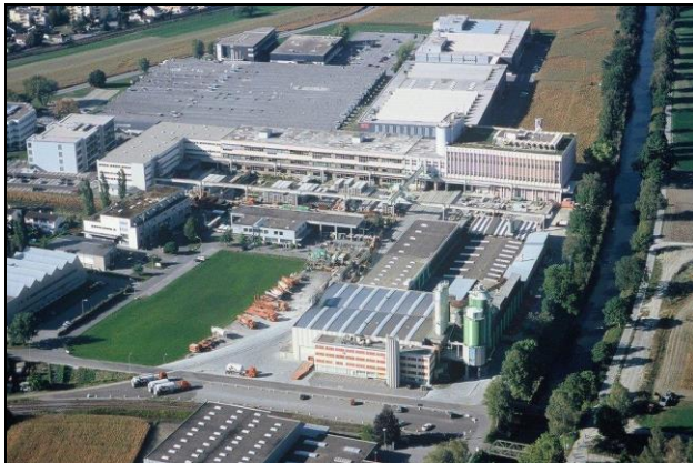
Areal der saw Gruppe aus Süden mit Produktion und Lager der saw spannbetonwerk ag im Vordergrund
